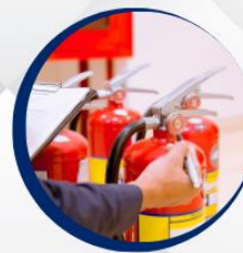
Extintores de Incêndio
