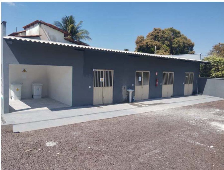
Imagem 09 – Abrigo de Higienização e Abrigo externo para armazenamento resíduos dos grupos A, D e E em conformidade com a RDC 222/2018.
