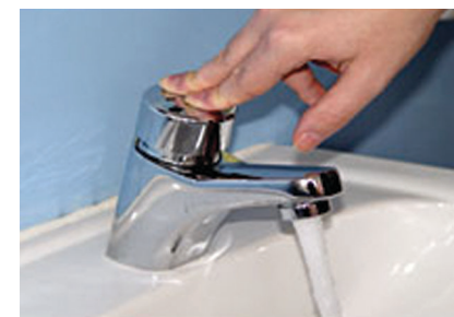
Torneira de acionamento com pressão e fechamento automático. Este tipo de torneira evita a contaminação das mãos após a higiene.
